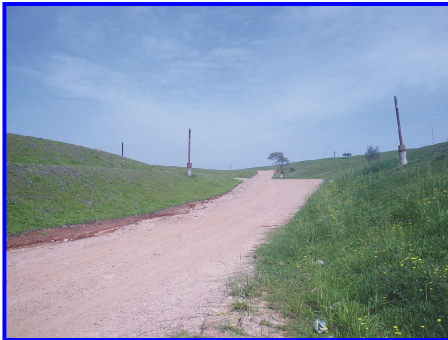
Figura 4.4.8 Célula sobreaterrada, com cobertura vegetal e as chaminés. Fonte: Local: Aterro Sanitário da Caximba. Pesquisa de campo (nov, 2006).
