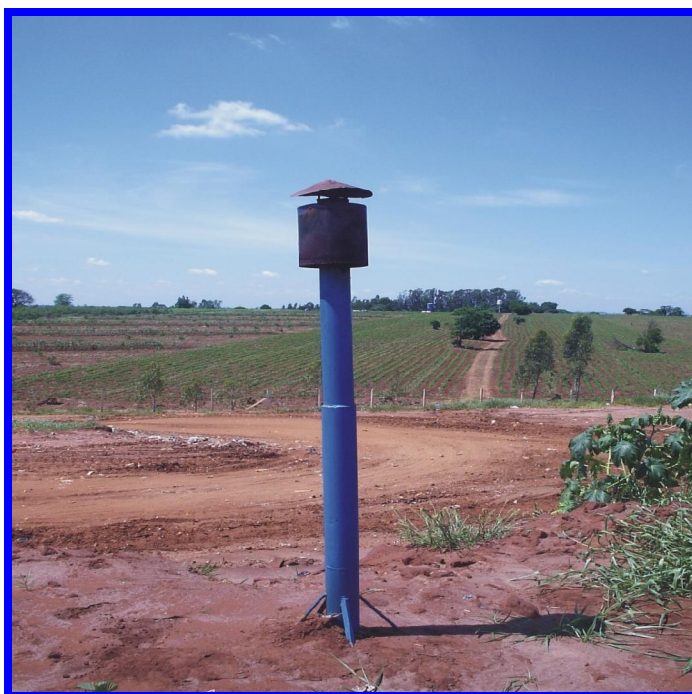
Figura 4.4.11 Chaminé por onde se queima o \text{CH}_4 . Fonte: Local: Aterro Sanitário da Caximba. Pesquisa de campo (nov, 2006).
