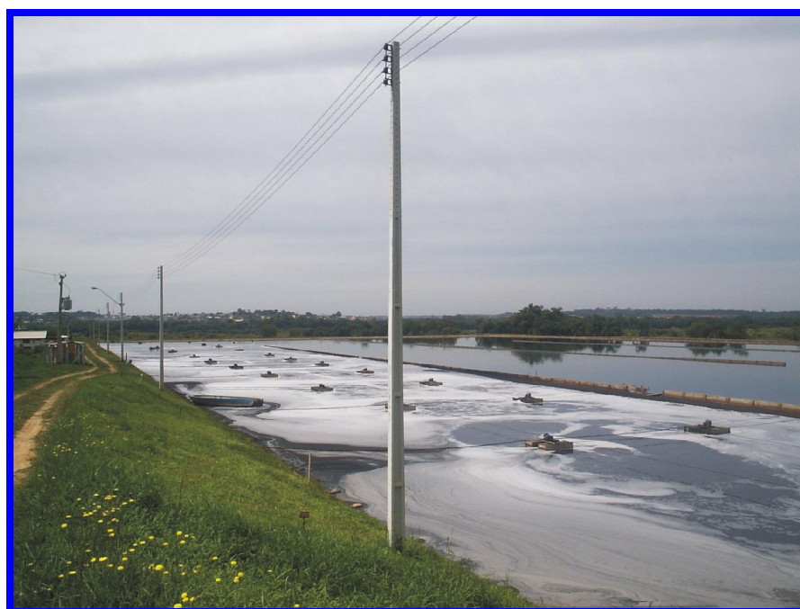
Figura 4.4.14 Lagoa de aeração do chorume. Fonte: Local: Aterro Sanitário da Caximba. Pesquisa de campo (nov, 2006).
