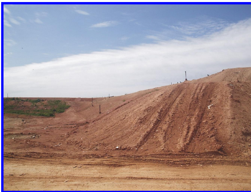
Figura 4.4.7 Célula sobreaterrada e com as chaminés instaladas. Fonte: Local: Aterro Sanitário da Caximba. Pesquisa de campo (nov, 2006).
