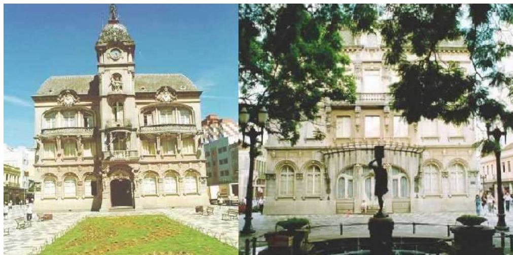
FOTO 3 Antigo prédio da Prefeitura Municipal de Curitiba. Disponível em: http://www.patrimoniocultural.pr.gov.br/modules/conteudo/conteudo.php?conteudo=198 Acesso em: 4 nov 2007
