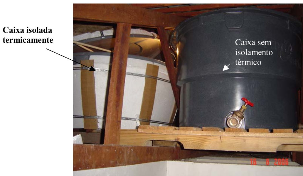
Ilustração 17 – Reservatório isolado termicamente e outro sem isolamento.
