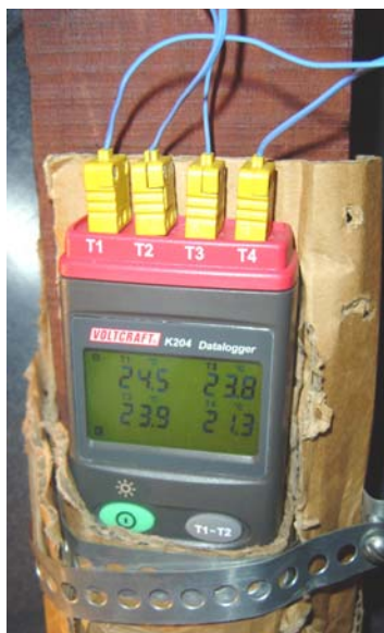
Ilustração 28 – Detalhe do datalogger posicionado na estrutura de madeira do telhado, próximo aos dois reservatórios.
