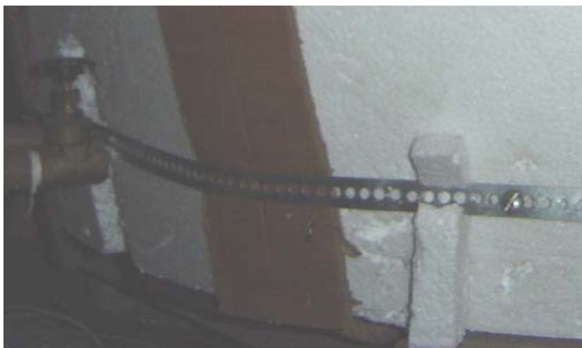
Ilustração 32 - Revestimento de EPS do reservatório – a cinta metálica prende as placas
