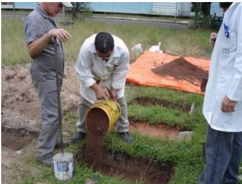
Figura 5.8 – Colocação do solo aditivado nas cavas
