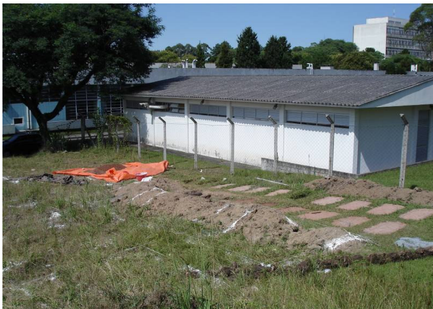
Figura 5.10 – Vista geral das cavas aditivadas
