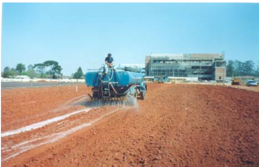
Figura 2.12 – Aplicação do EMC 2
