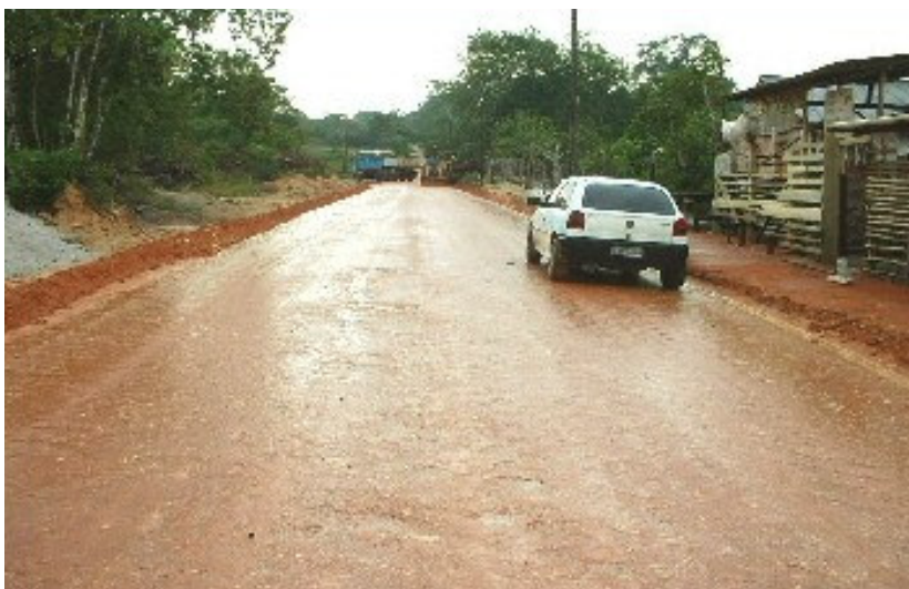
Figura 2.15 – Rua estabilizada com Ecolopavi
