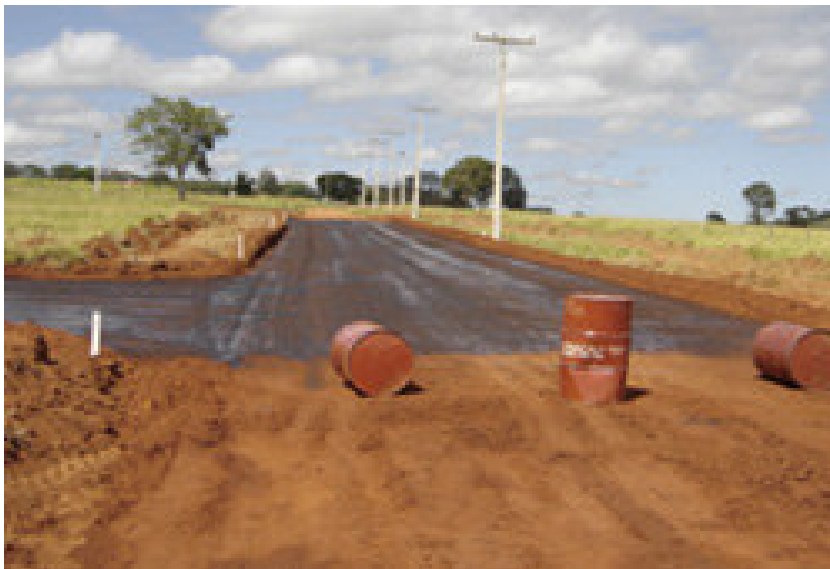
Figura 2.16 – Trecho tratado com Dynacal
