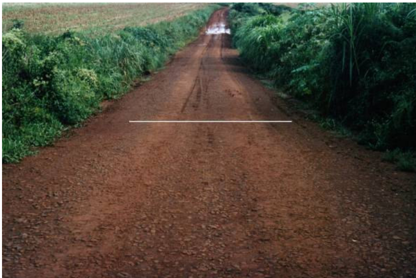
Figura 2.13 Interseção entre trecho tratado e não tratado
