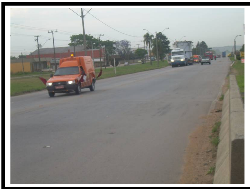
Figura 14 - FRG/PR - Vista parcial do Trecho da BR-116 em frente ao Posto 21 - 6h40min
