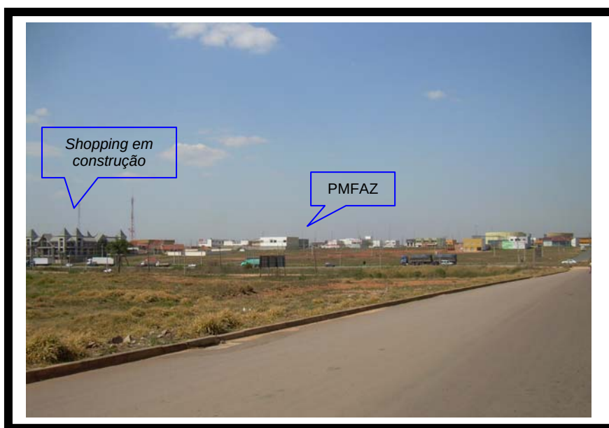
Figura 26 – FRG/PR - Vista parcial do centro - espaços vazios e o corte da BR-116
