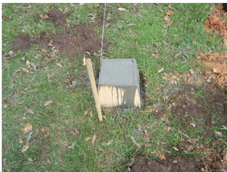
FIGURA 4.5 - CONCRETAGEM DAS RRNN
