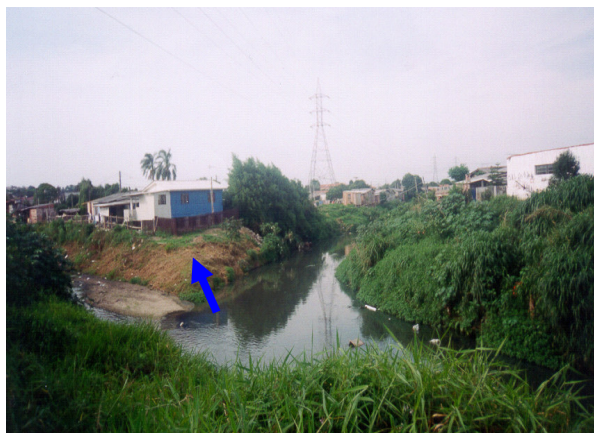
E) Ponto de desembocadura do rio Bacacheri no rio Atuba –bairro Capão da Imbuia/ Curitiba. Exemplo de ocupação desordenada sujeita as inundações na margem direita do rio Atuba.
