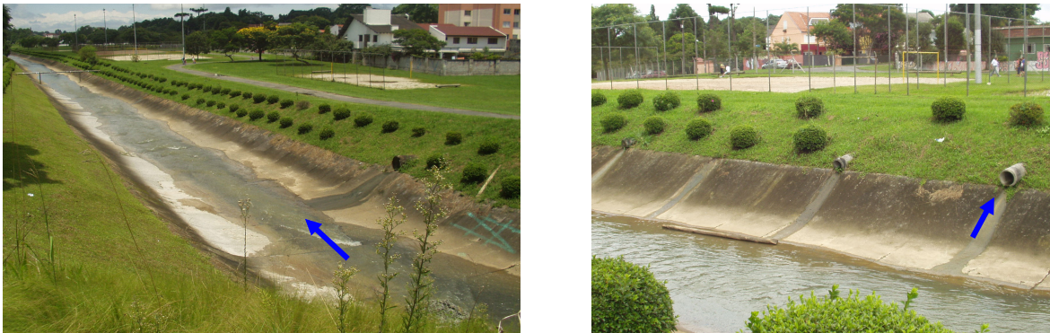
A) Exemplo de medidas intensivas - retificação do canal de drenagem do rio Bacacheri e sistema de dutos de drenagem artificial, que conduzem as águas pluviais até o leito do rio / Parque-Bacacheri (Bairro do Bacacheri).
