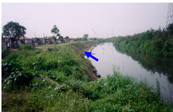
C) Médio curso do rio Atuba com ocupação ao longo da margem direita e processo de erosão ocasionado pela retirada da mata ciliar.
