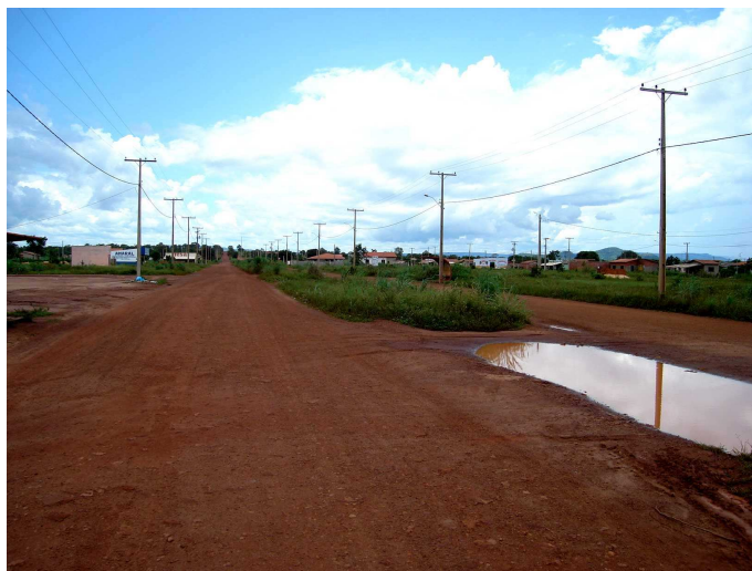
FIGURA 29 – AVENIDA PRINCIPAL DO BAIRRO JARDIM TAQUARI FONTE: XAVIER, 2007.
