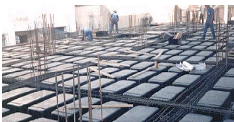
FIGURA 5 – DETALHE DAS LAJES COM USO DE FORMAS PLÁSTICAS FONTE: CATÁLOGO ATEX, 2006.
