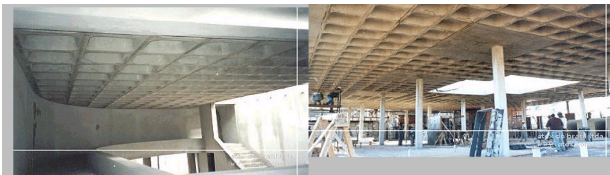
FIGURA 5 – DETALHE DAS LAJES COM USO DE FORMAS PLÁSTICAS FONTE: CATÁLOGO ATEX, 2006.
