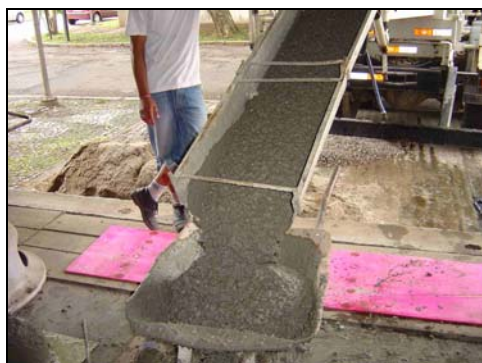
FOTOS 3.29: CONCRETAGEM DAS LAJES
