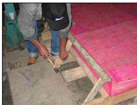
FOTO 3.13: EXECUÇÃO DAS FORMAS
