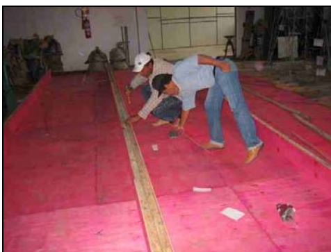
FOTO 3.12: EXECUÇÃO DAS FORMAS
