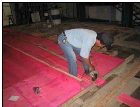
FOTO 3.11: EXECUÇÃO DAS FORMAS
