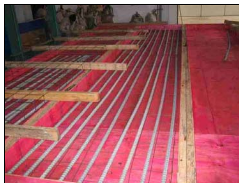
FOTO 3.19: ARMAÇÃO DAS LAJES
