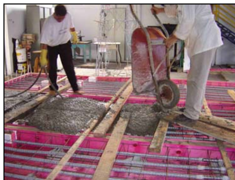
FOTO 3.30: CONCRETAGEM DAS LAJES
