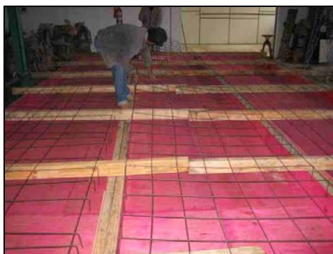
FOTO 3.18: ARMAÇÃO DAS LAJES
