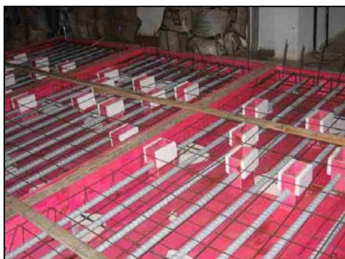
FOTO 3.20: ARMAÇÃO DAS LAJES
