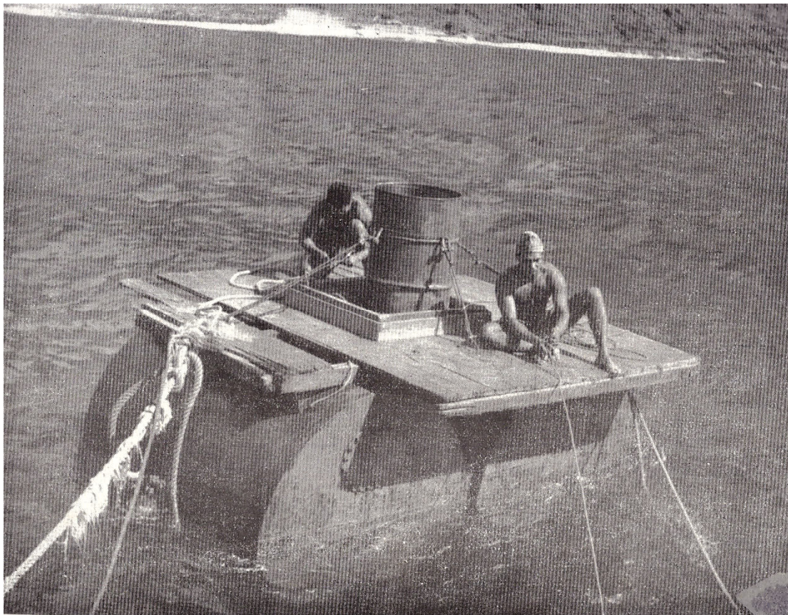
Figura 12: O desembarque dos equipamentos e materiais de construção através de balsas em 1957 (Mayer 1957).
