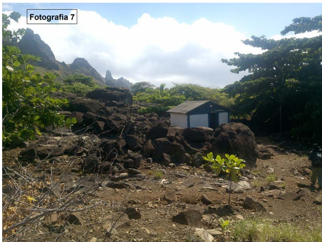
Figura 58: Fotografia 7 - Mostra a área de deposição, nas proximidades das edificações, de grandes blocos de rochas vulcânicas que se deslocaram de altitudes mais altas (LECOST - UFPR 2016).
