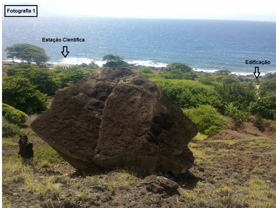
Figura 52: Fotografia 1 - Bloco rolado nas proximidades dos alojamentos da Marinha do Brasil e da base científica na Praia dos Portugueses. Nota: edificações em situação vulnerável (LECOST – UFPR 2016).
