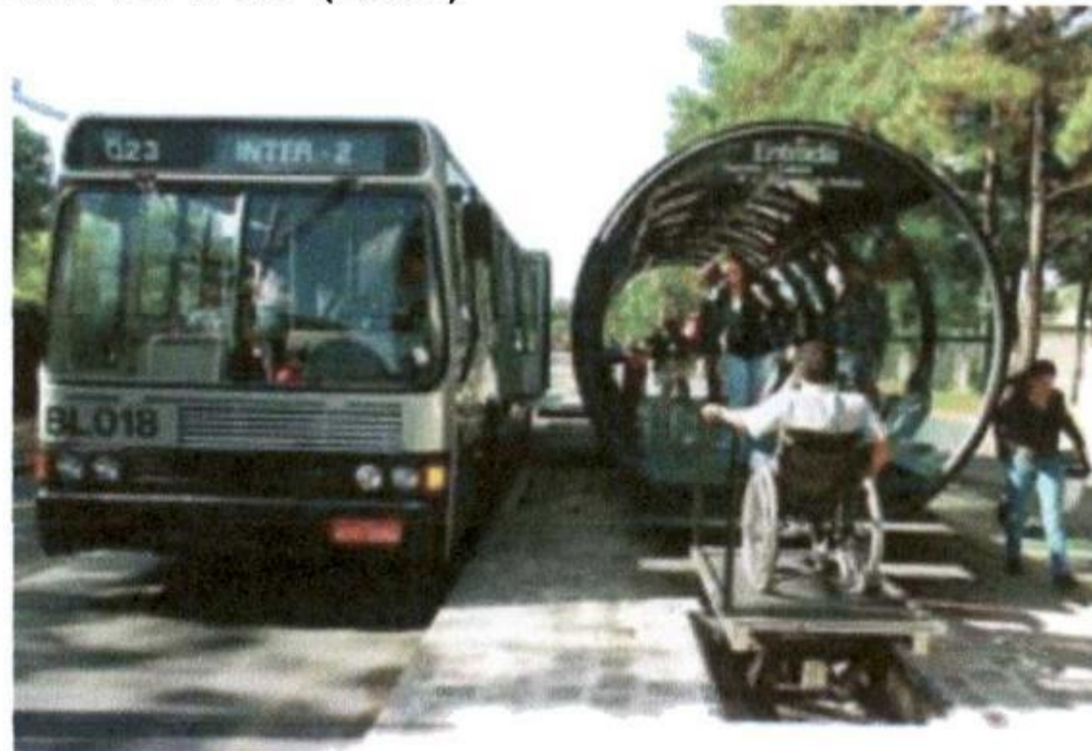
FIGURA 18. Estação Tubo adaptada FONTE: IPPUC (2008)
