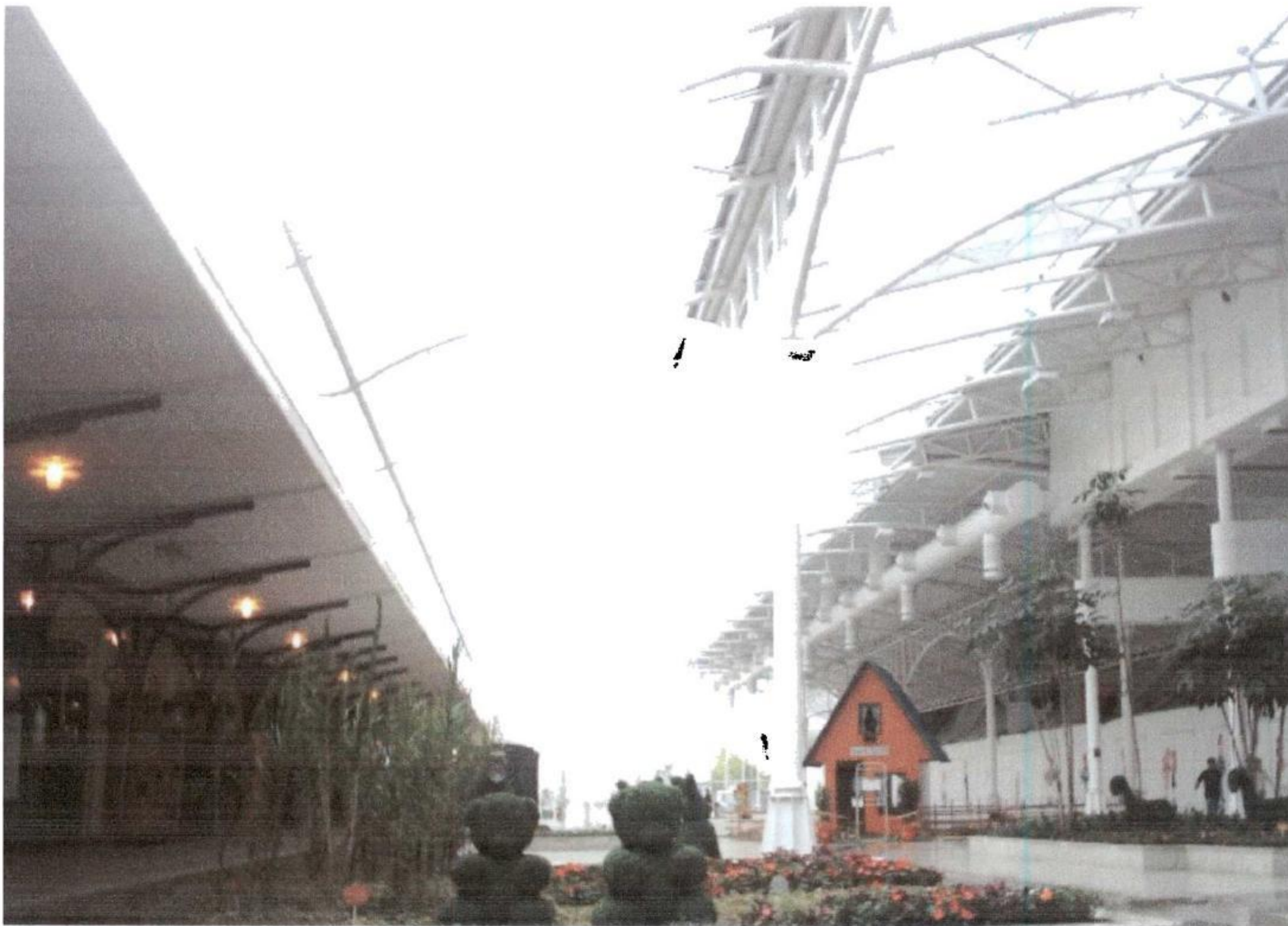
FIGURA 11 – TELHADO ESTAÇÃO PLAZA SHOPPING – CURITIBA / PR
