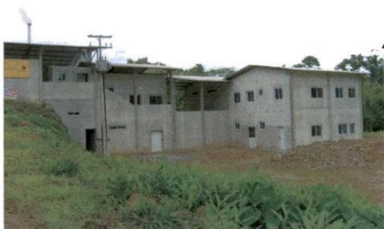
Fachada do alambique (ainda em obras).
