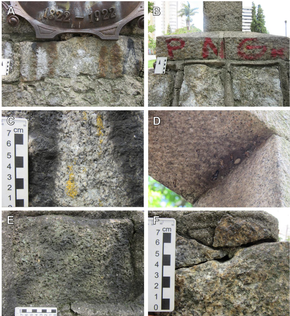
FIGURA 25 – a) Manchas de óxido de ferro b) Pichação; c) Salpicos de tinta amarela e pichação; d) Colonização biológica de lagartas; e) Perda de matriz; f) Filmes negros.
