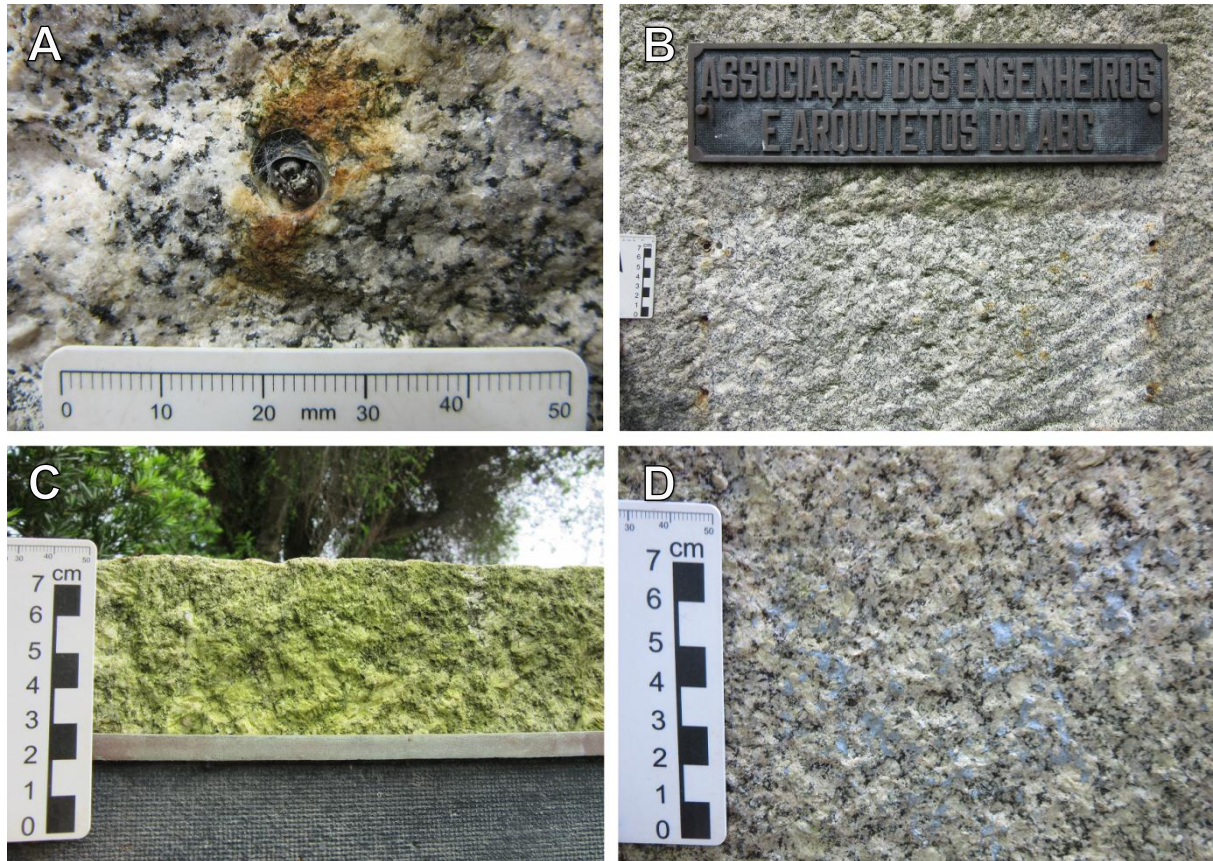
FIGURA 26 – a) Perfuração com colonização de aranhas e manchas de óxido de ferro; b) Filmes negros; c) Colonização de musgos no topo do monumento; d) Depósitos de argamassa.
