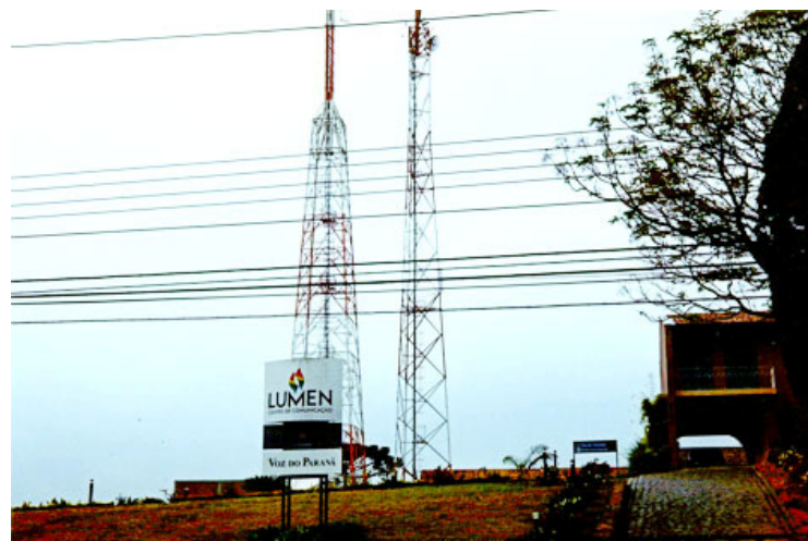
Figura 3.4 – Vista do portão de entrada do CCL
