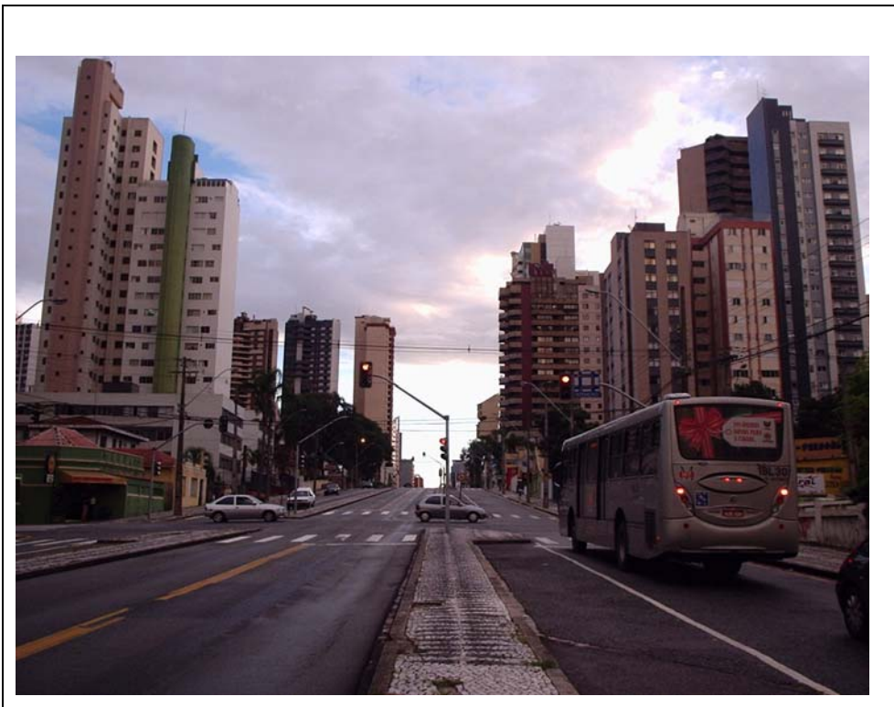
Fotografia 6 – Vista da canaleta do expresso no SEE-N.
