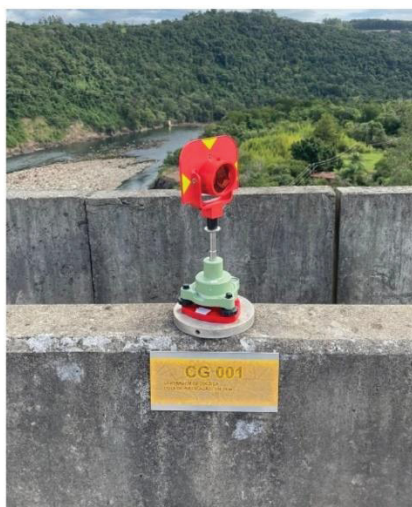
Figura 4 – Ponto localizado na crista da barragem (CG01). Fonte: Autores (2021).
