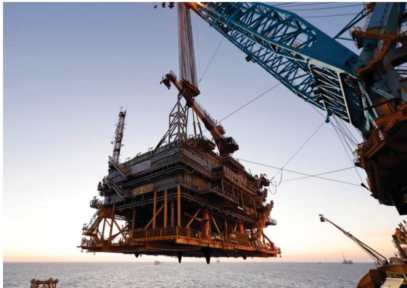
Figura 7– Subestação eólica -SEO.
