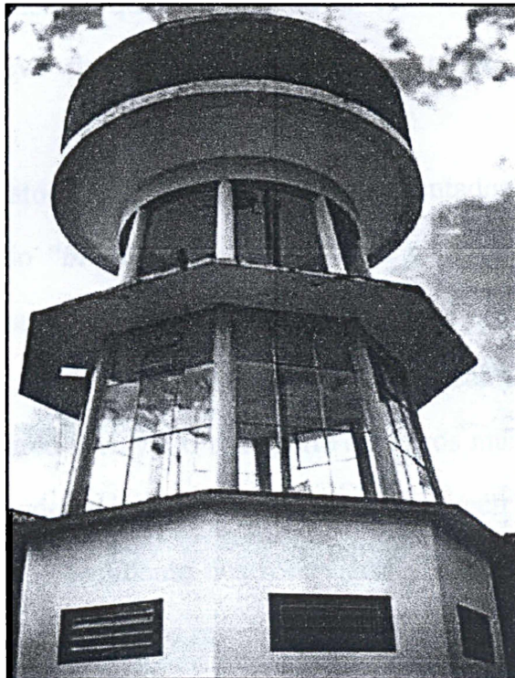
FIGURA 1 - VISTA GERAL DO RESERVATÓRIO R1
