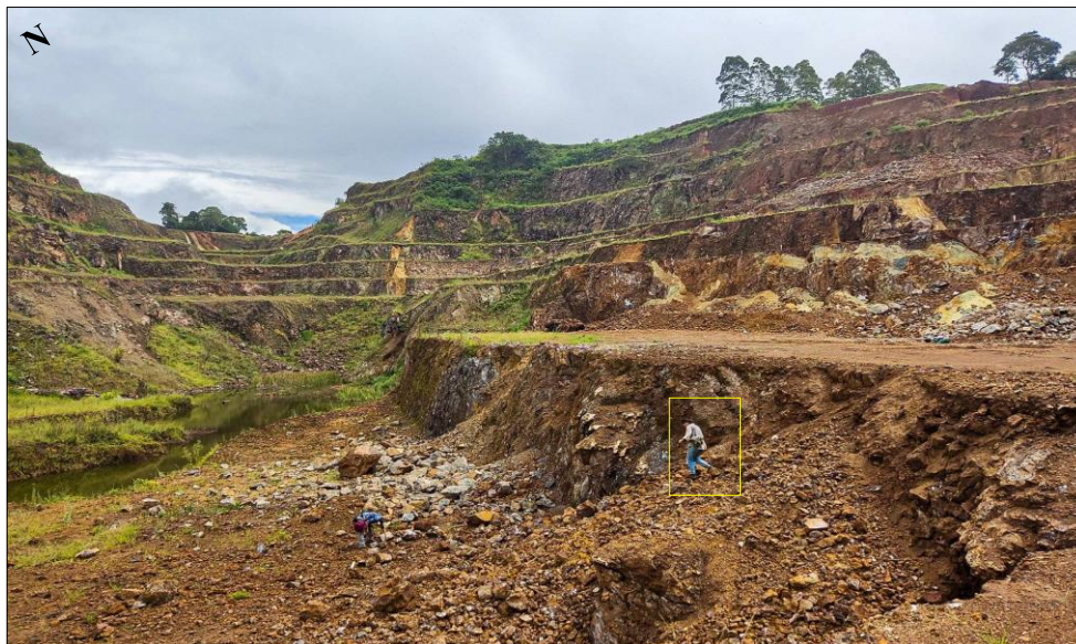
Figura 3 - Visão geral de uma das frentes de lavra com diversas bancadas da jazida de fluorita da Mineração Nossa Senhora do Carmo. O trabalho de amostragem foi concentrado nessas bancadas e nas pilhas de detonação, na base delas. Em destaque no polígono amarelo: pessoa com 1,65 m de escala na foto.
