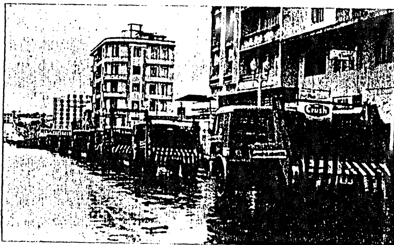
Equipamento adequado: caminhões e máquinas adquiridos na gestão.
