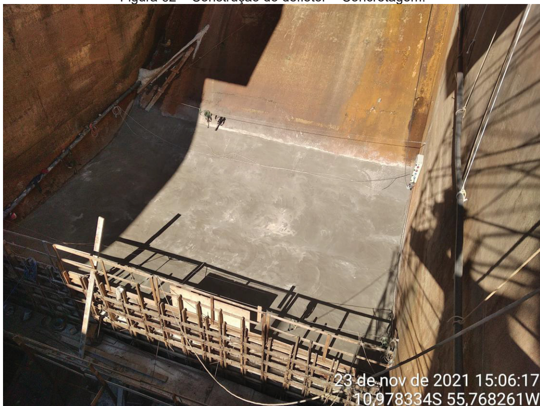
Figura 62 – Construção do defletor – Concretagem.
