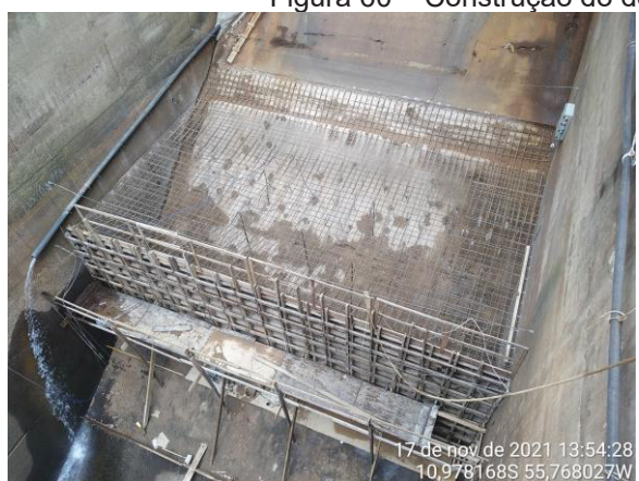
Figura 60 – Construção do defletor – Detalhe da armadura.
