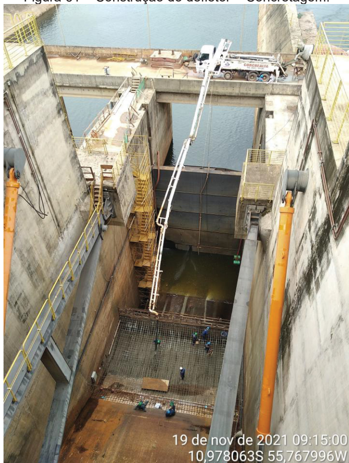
Figura 61 – Construção do defletor – Concretagem.
