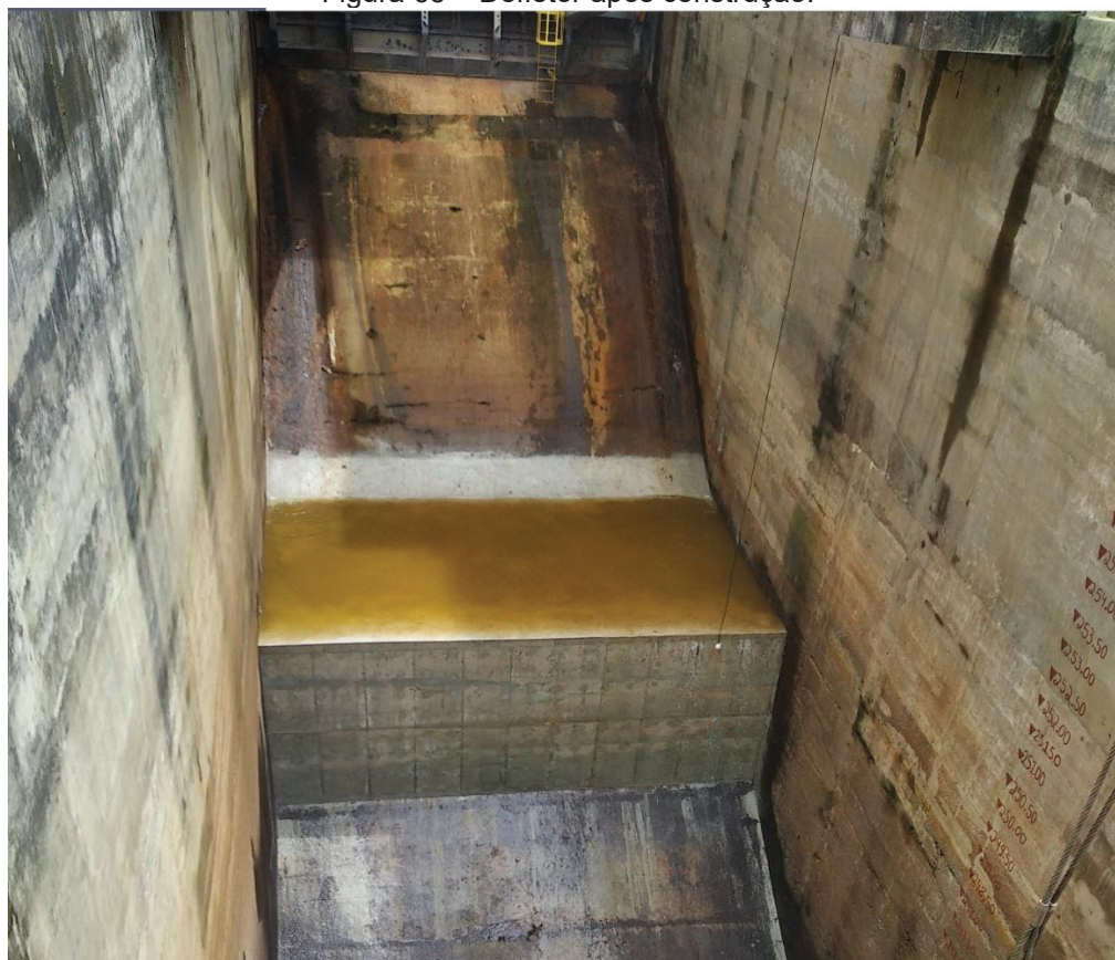
Figura 63 – Defletor após construção.
