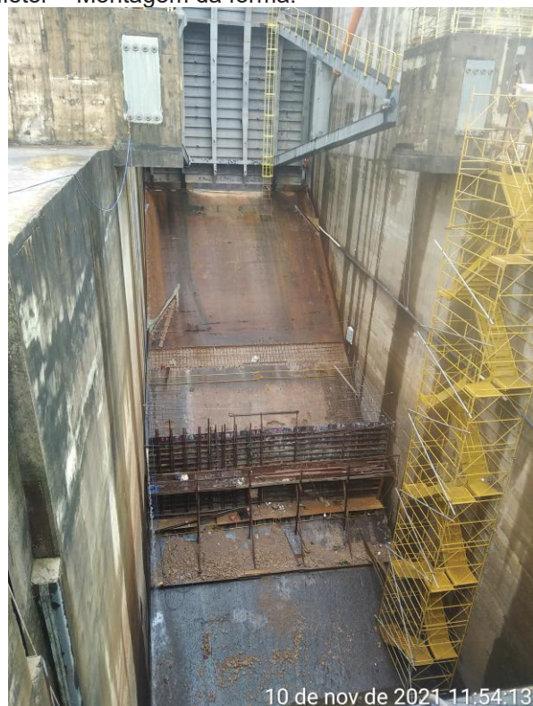
Figura 59 – Construção do defletor – Montagem da forma.
