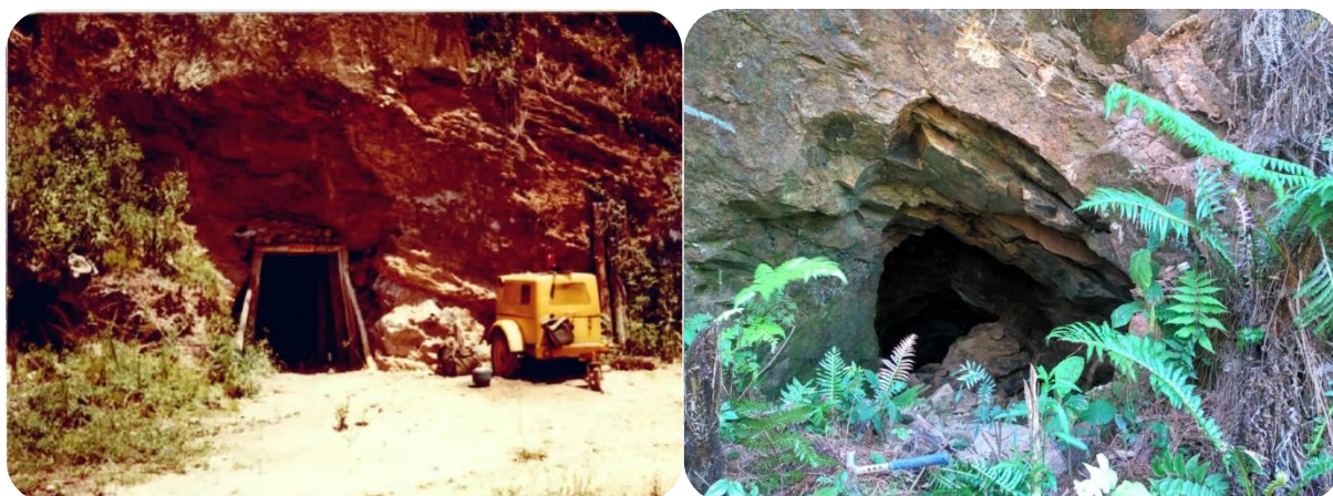
Figura 02: À esquerda fotografia da galeria Paiol ainda em atividade, (Takahashi et al. , 1983). À direita fotografia das condições atuais da mesma galeria, estando parcialmente obstruída por blocos.
