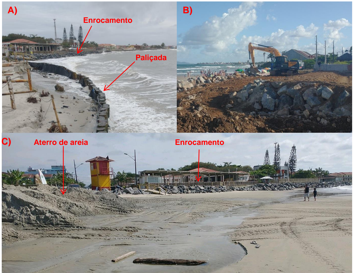
Figura 2: A) Estruturas rígidas, agosto/2021. B) Instalação de enrocamento, janeiro/2023. C) Aterro de areia instalado em abril/2021.
