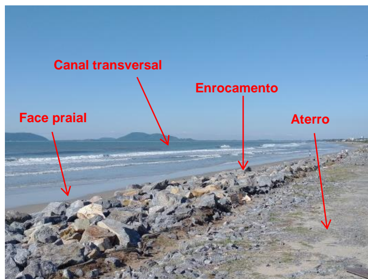
Figura 11: Enrocamento e aterro em via pública.
