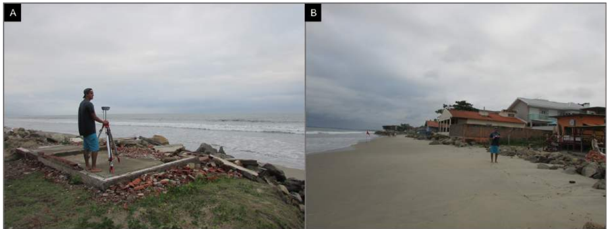
Figura 8: A) Instalação da estação base para o levantamento do Perfil-05, sob antiga construção destruída pelo processo erosivo. B) Perfil-05 durante a segunda etapa, evidenciando o grande impacto da erosão (visada para sul).
