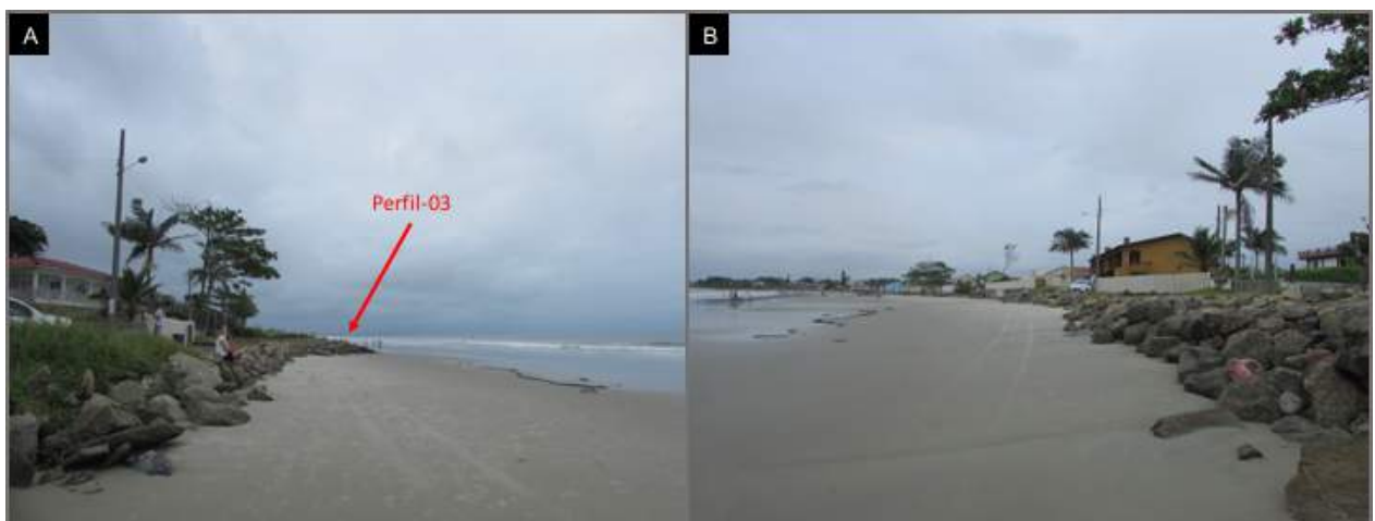
Figura 6: A) Localização do Perfil-03, atrás dos enrocamentos (visada para norte). B) Utilização de enrocamentos em região próxima ao Perfil-03 (visada para sul).
