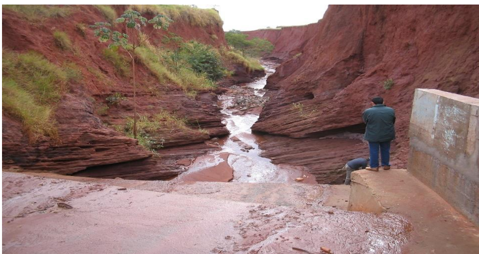
Figura 20: Exutório de emissário com erosão atingindo e expondo a Grupo Caiuá no município de Terra Rica. Fonte: MINEROPAR, 2006.
