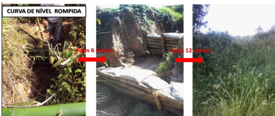
Figura 9: Monitoramento entre o momento de construção das barreiras de bambu e doze meses depois do estabelecimento das mesmas. Fonte Baldassarini, 2014.
