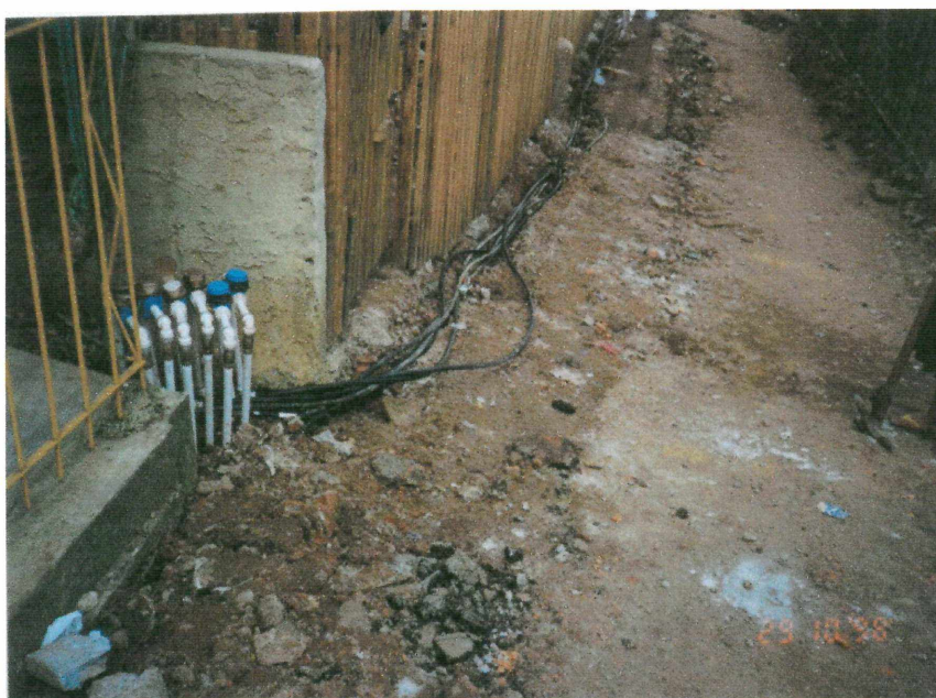
FIGURA 14 - MODELO DE INSTALAÇÃO DE TORNEIRAS COMUNITÁRIAS
