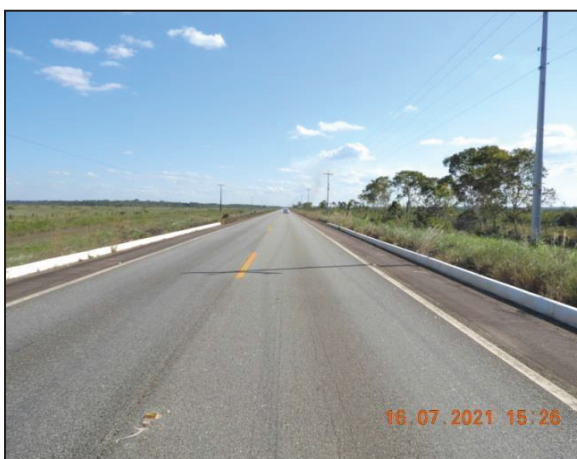
Figura 8. Trecho Sul B, pavimentado em ótimas condições de trafegabilidade.
