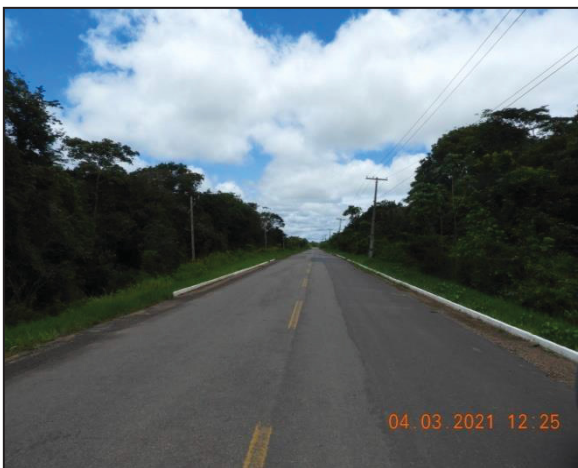
Figura 2. Trecho Norte A, pavimentado. Boas condições de trafegabilidade.
