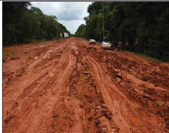
Figura 4. Trecho Norte C, partes são pavimentadas e outras partes não, conhecidas como trecho misto.
