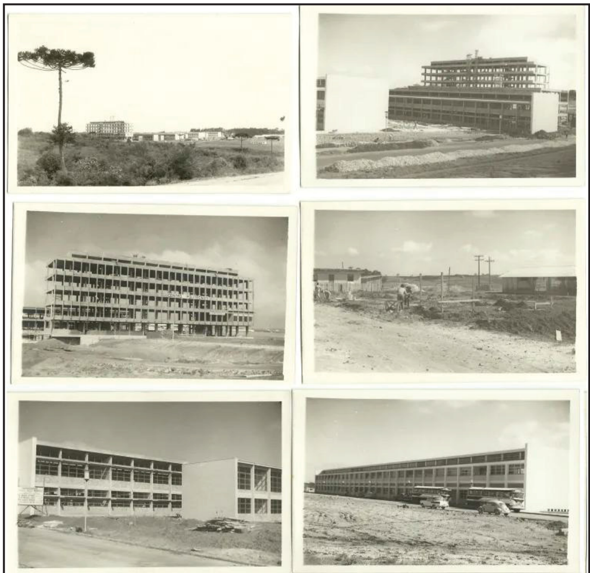
Figura 9 - Fotografias históricas do período de obras do Campus. Fonte: Projeto de Extensão – Resgate arquitetônico e estrutural do complexo Rubens Meister – Grupo Estruturas UFPR
