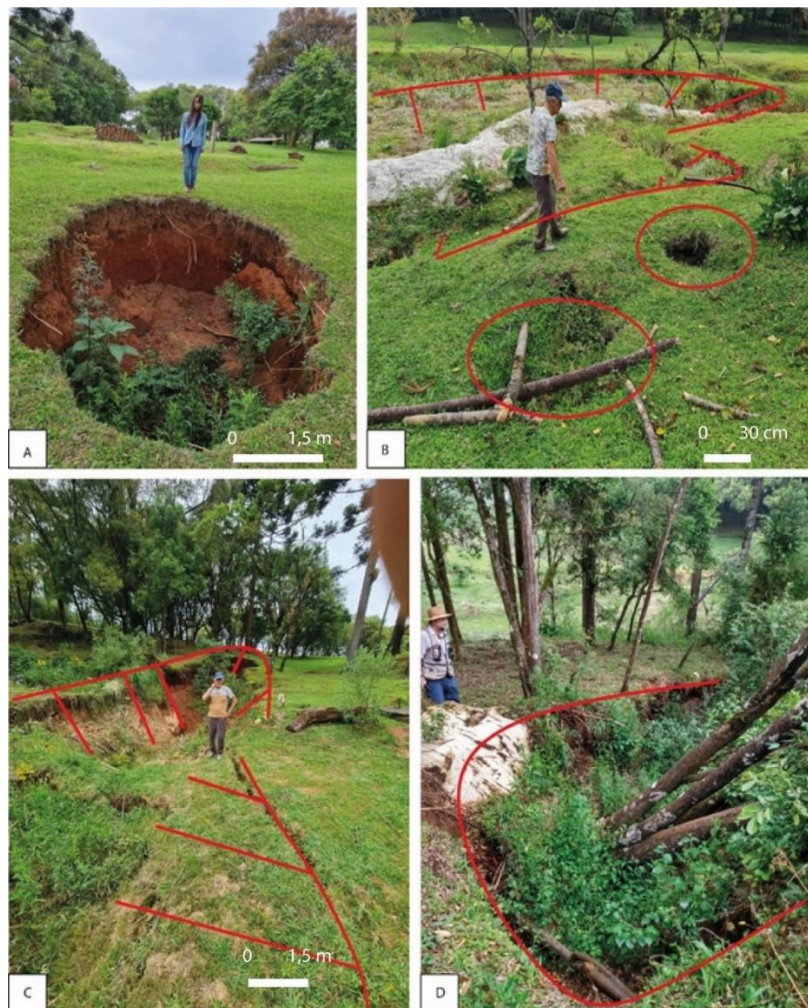
Figura 18: Dolinas por Colapso de Solo (A) Simétrica e Simples, (B) Assimétrica estrutural e Simétricas alinhadas indicando controle estrutural, (C) Assimétrica estrutural e (D) Assimétrica Estrutural. Fonte: Fotos Lima. R.E., novembro (2022).
