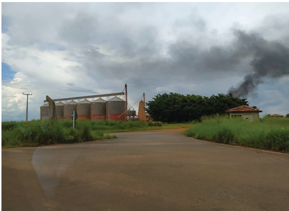
FIGURA 10 – SILOS ABANDONADOS (COACERAL)
