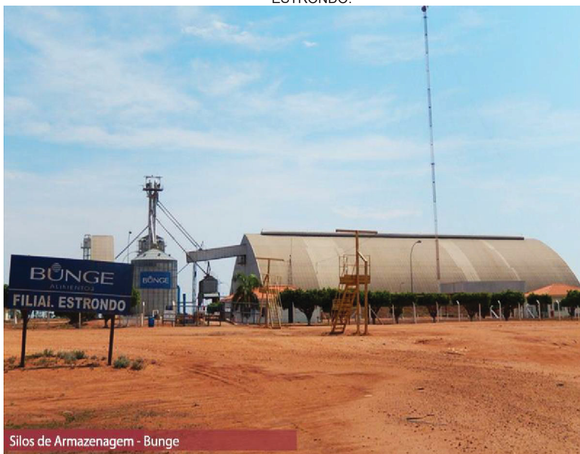
FIGURA 13 - SILO DA BUNGE LOCALIZADO DENTRO DOS LIMITES DO CONDOMÍNIO ESTRONDO.
