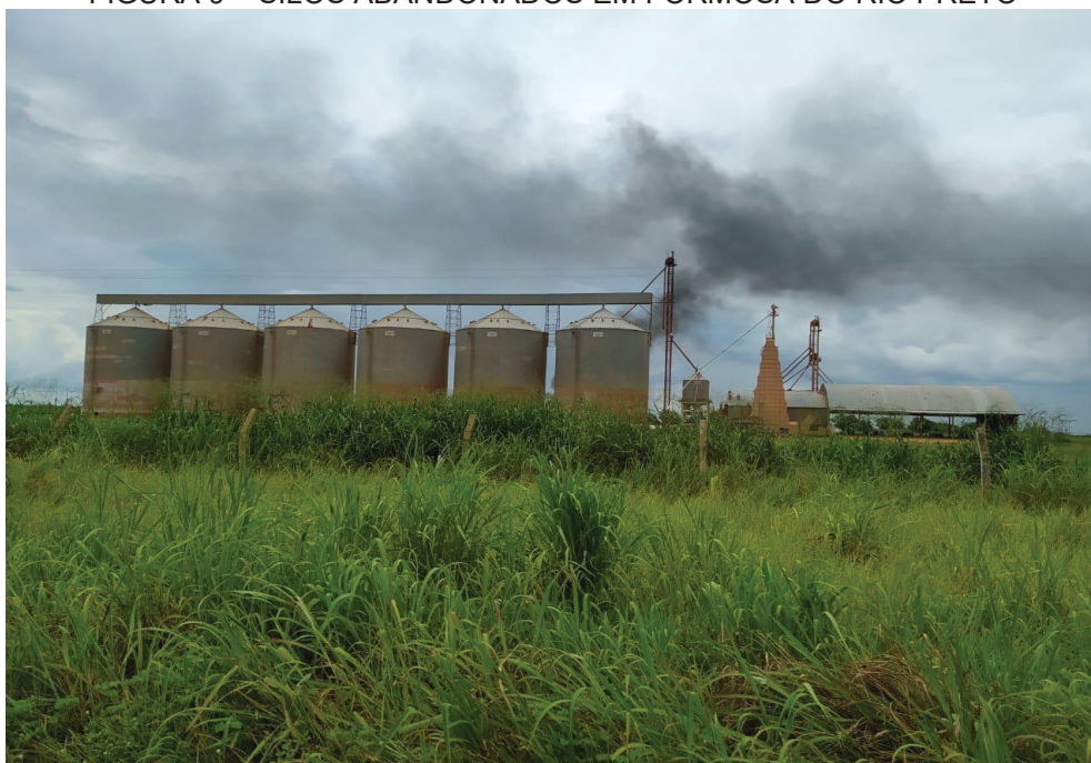
FIGURA 9 – SILOS ABANDONADOS EM FORMOSA DO RIO PRETO
