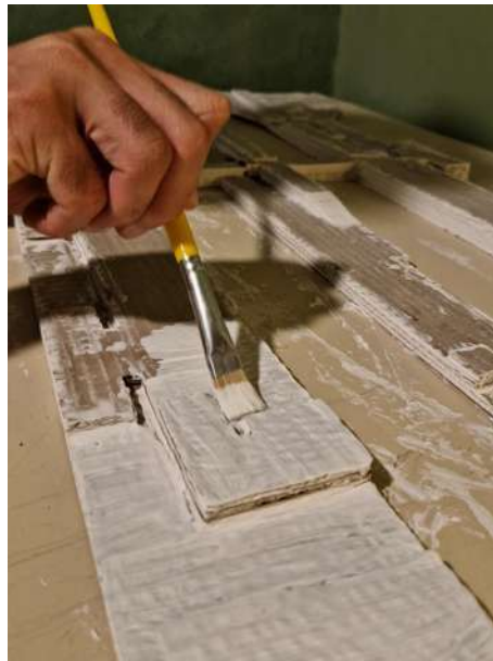
Figura 45: Aplicação de tinta PVA
