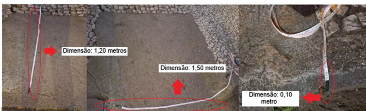
FIGURA 36 – RAMPA 1: 10 CM DE ALTURA, 1,20 M DE COMPRIMENTO, INCLINAÇÃO 8,33%
