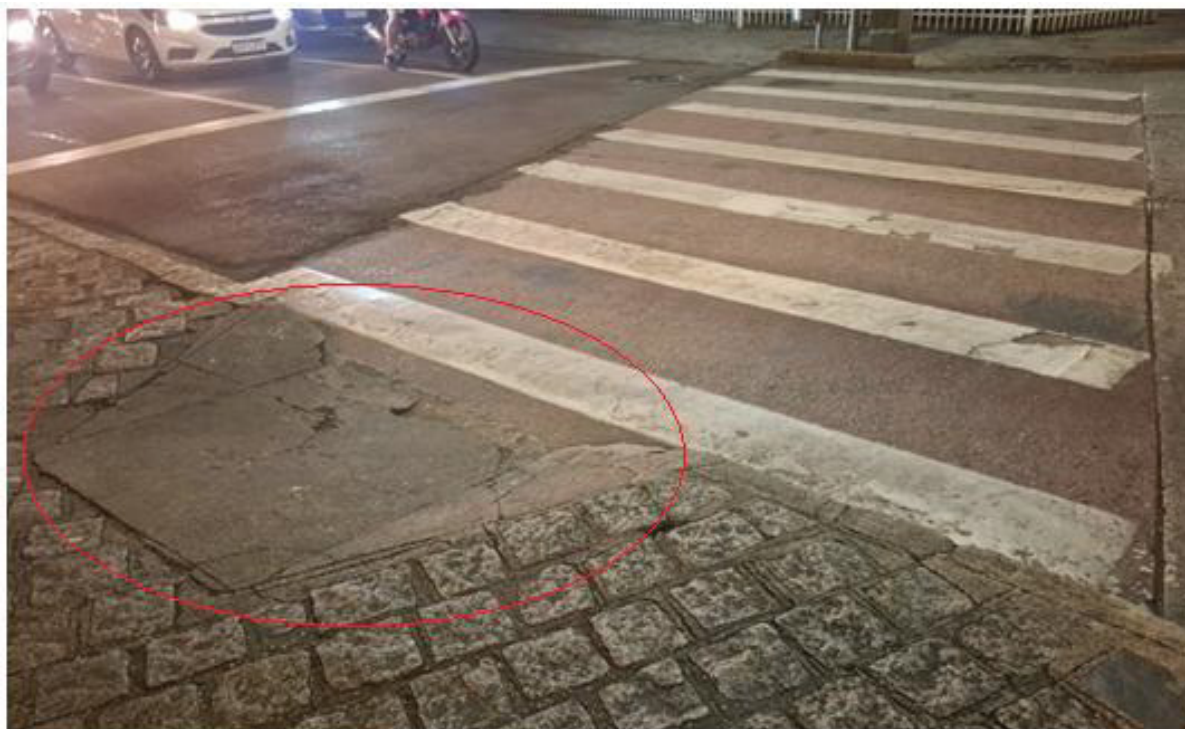
FIGURA 44 – RAMPA: 18 CM DE ALTURA, 1,20 M DE COMPRIMENTO, INCLINAÇÃO 15%
