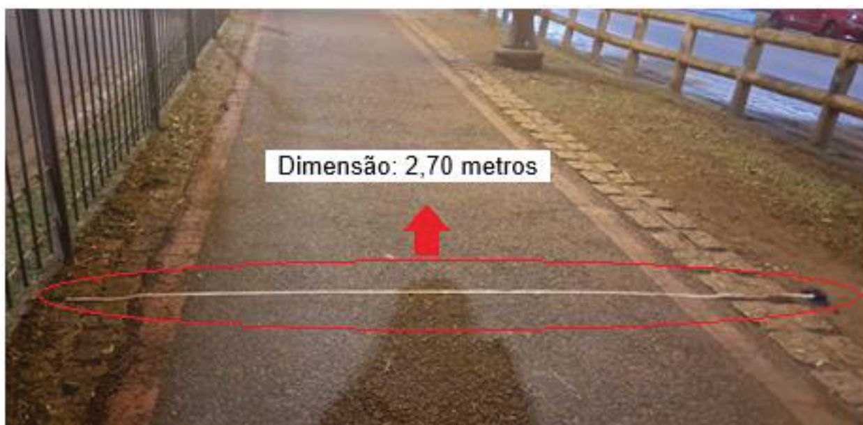
FIGURA 43 – LARGURA DA CALÇADA NA RUA PRESIDENTE CARLOS CAVALCANTI: 2,70 METROS
