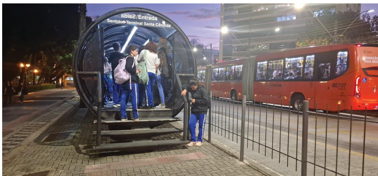
FIGURA 24 – LADO DA ESTAÇÃO SEM PLATAFORMA ELEVATÓRIA
