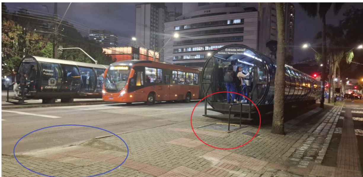
FIGURA 23 – PLATAFORMA ELEVATÓRIA ESTAÇÃO TUBO PASSEIO PÚBLICO
