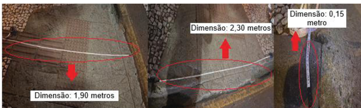
FIGURA 37 – RAMPA 2: 15 CM DE ALTURA, 1,90 M DE COMPRIMENTO, INCLINAÇÃO 7,89%
