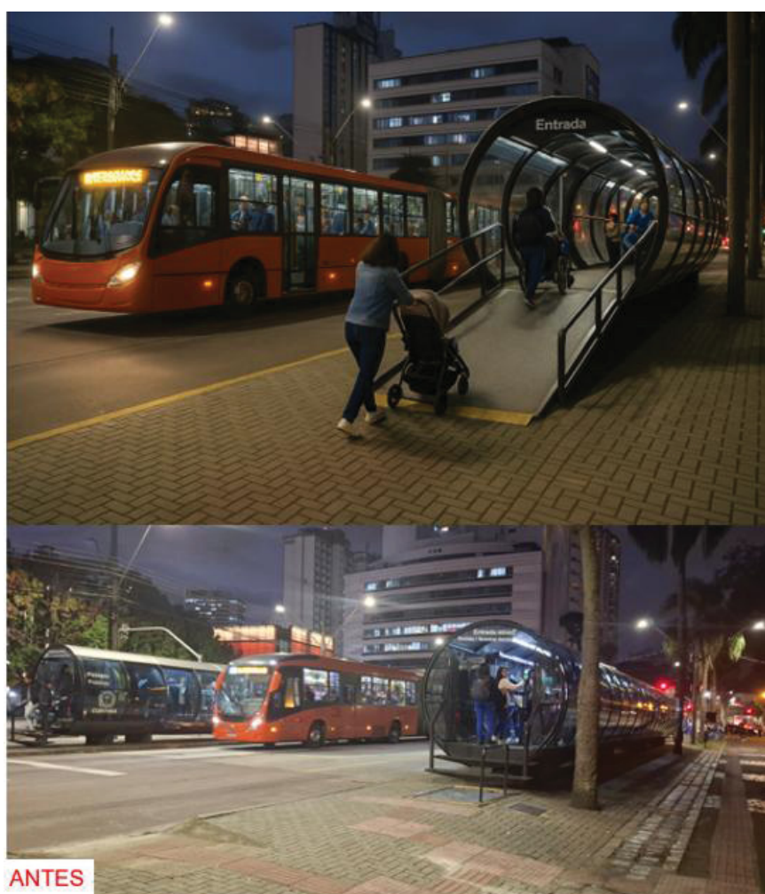
FIGURA 62 – RAMPA ACESSÍVEL NO LUGAR DO ELEVADOR
