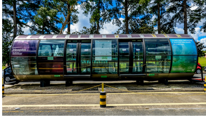
FIGURA 23 – Estação Tubo de Ensaio situada no Centro Politécnico da UFPR, em Curitiba. A estrutura foi utilizada como modelo experimental para a aplicação de painéis fotovoltaicos orgânicos (OPVs). Fonte: Marcos Solivan Camargo.
