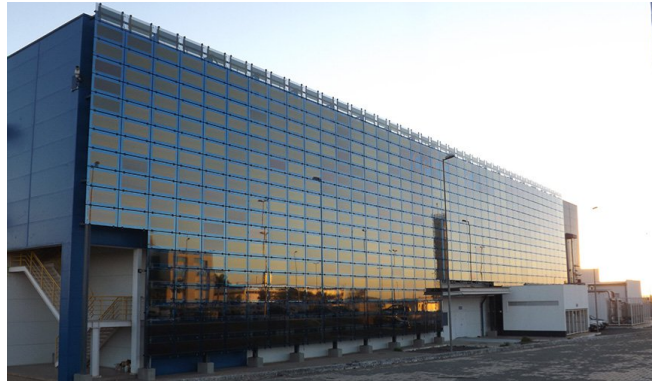
FIGURA 21 – Fachada do Centro de Pesquisas e Eficiência Energética, localizado em Anápolis (GO), onde foram instalados painéis fotovoltaicos orgânicos cobrindo aproximadamente 850 m 2 da estrutura [122].
