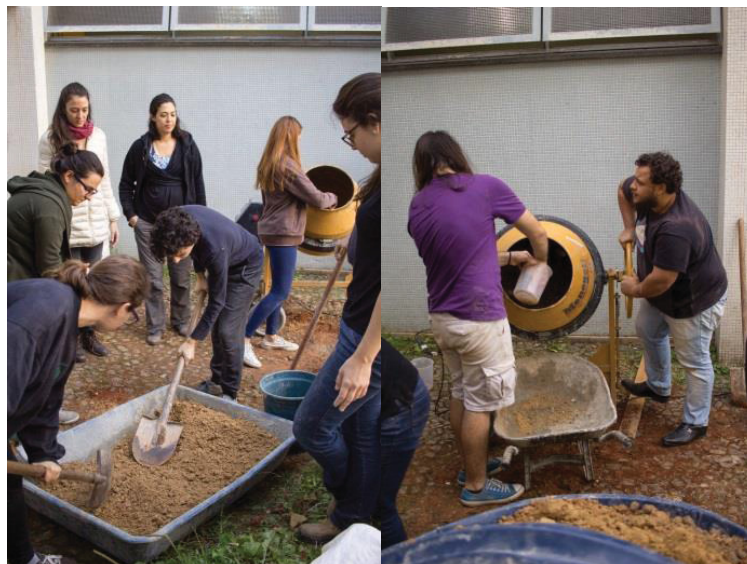
FIGURA 35 - MISTURA DOS SOLOS NA CAIXA E BETONEIRA
