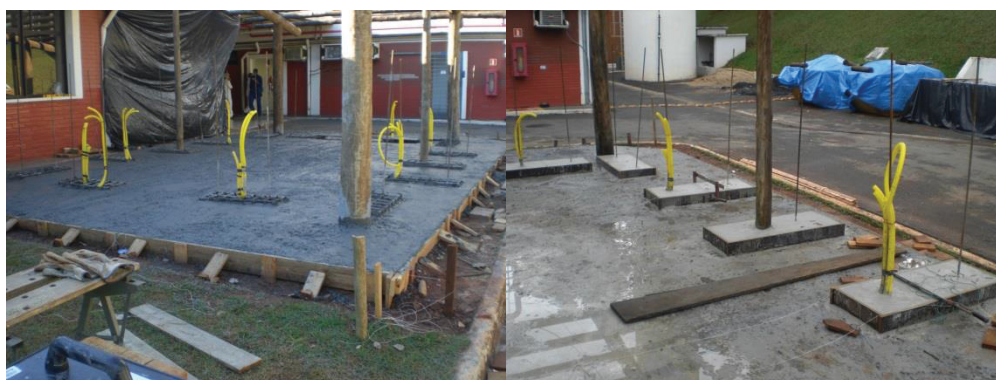
FIGURA 21 – BARRAS DE AÇO NA FUNDAÇÃO
