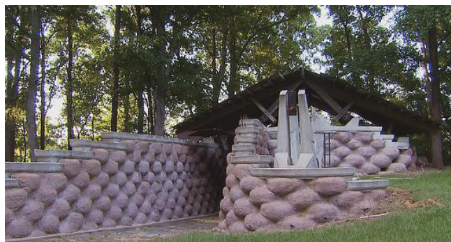
FIGURA 5 – TÉCNICA DE CONSTRUÇÃO COM TERRA: PREENCHER
