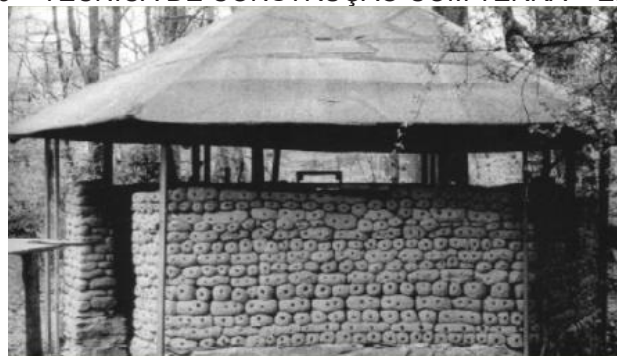
FIGURA 9 – TÉCNICA DE CONSTRUÇÃO COM TERRA – EMPILHAR
