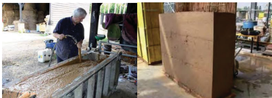
FIGURA 13 – TÉCNICA DE CONSTRUÇÃO COM TERRA – DERRAMAR
