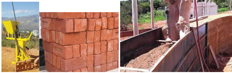
FIGURA 7 – TÉCNICA DE CONSTRUÇÃO COM TERRA: COMPACTAR
