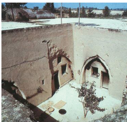
FIGURA 3 – TÉCNICA DE CONSTRUÇÃO COM TERRA: ESCAVAR
