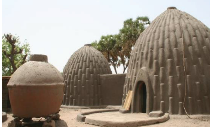
FIGURA 8 – TÉCNICA DE CONSTRUÇÃO COM TERRA – MOLDAR
