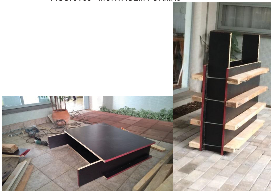
FIGURA 38 - MONTAGEM FORMAS
