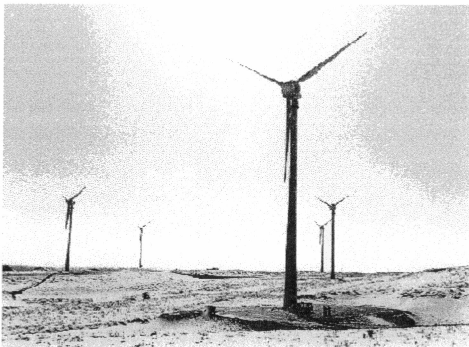
FIGURA 20 – FOTO DA USINA EÓLICA DE TAÍBA
