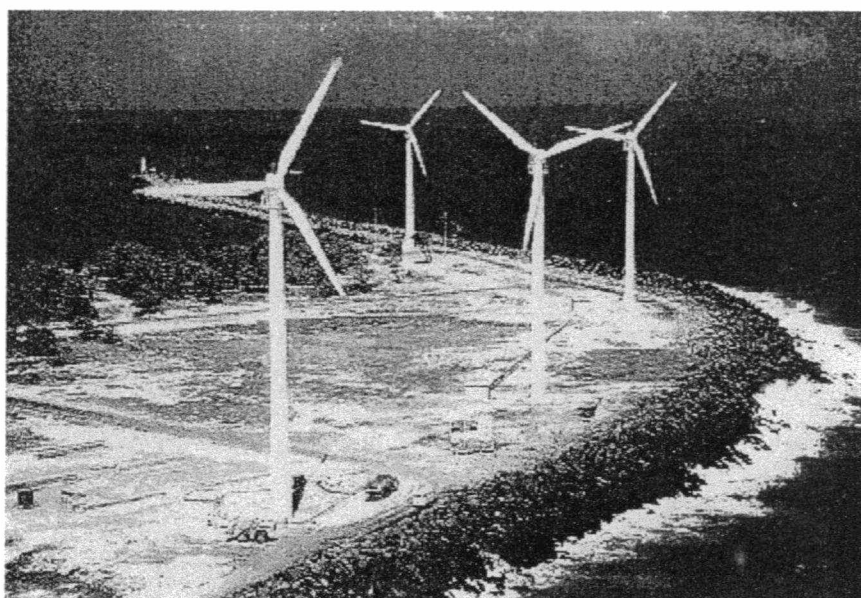
FIGURA 18 – FOTO DA FAZENDA EÓLICA EM PORTO DO MUCURIBE
