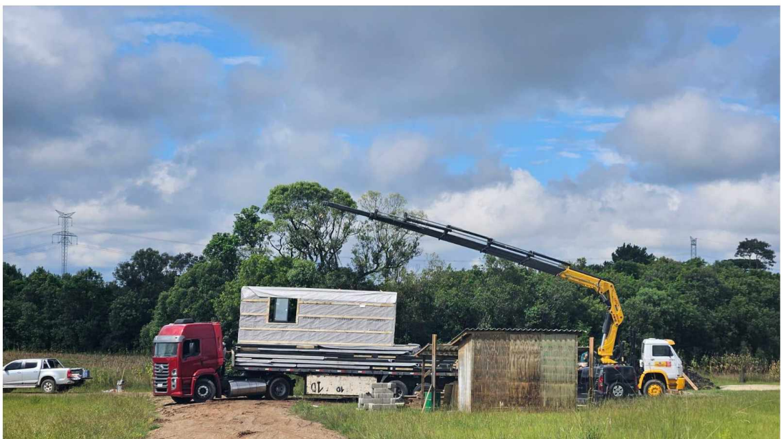
FIGURA 6 - Munck fazendo o içamento do painel
