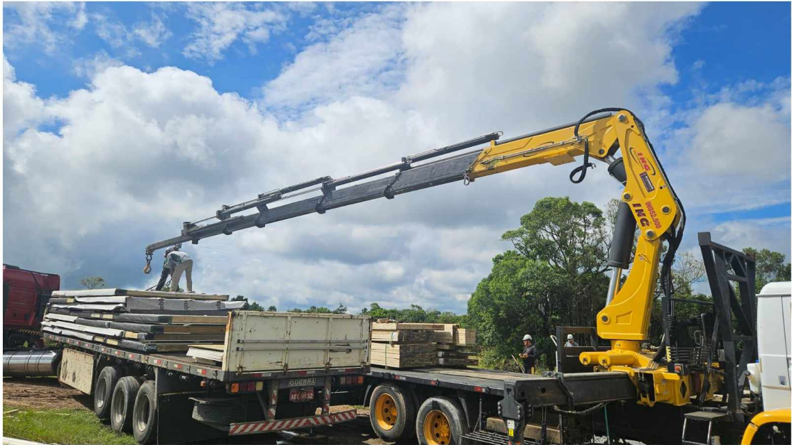
FIGURA 5 - Funcionário colocando cinta de içamento no painel
