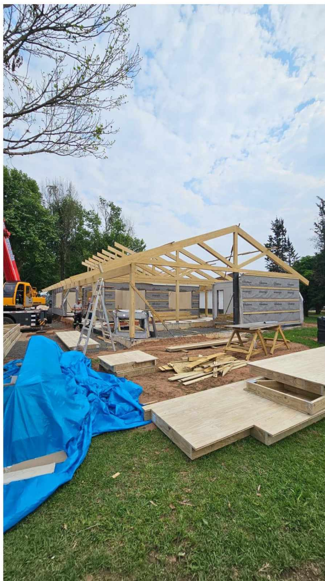
FIGURA 4 - Sistema Light Wood Frame
