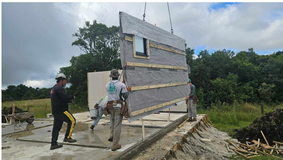
FIGURA 7 - Fixação do painel sobre a fundação
