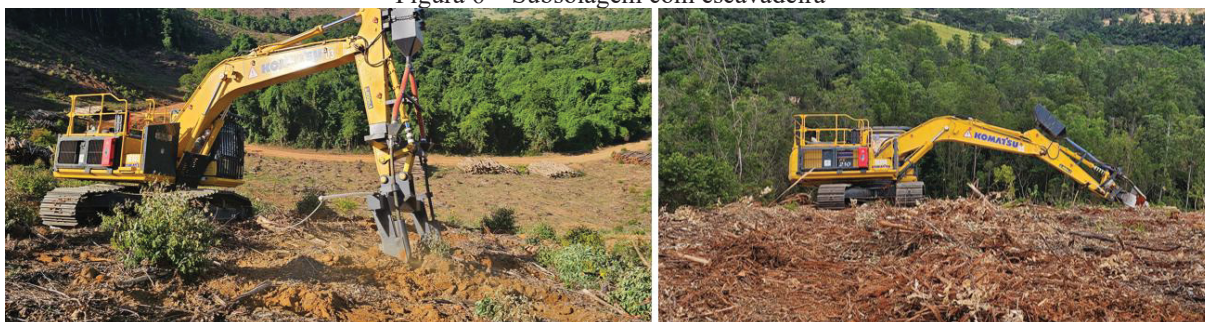
Figura 6 – Subsolação com escavadeira
