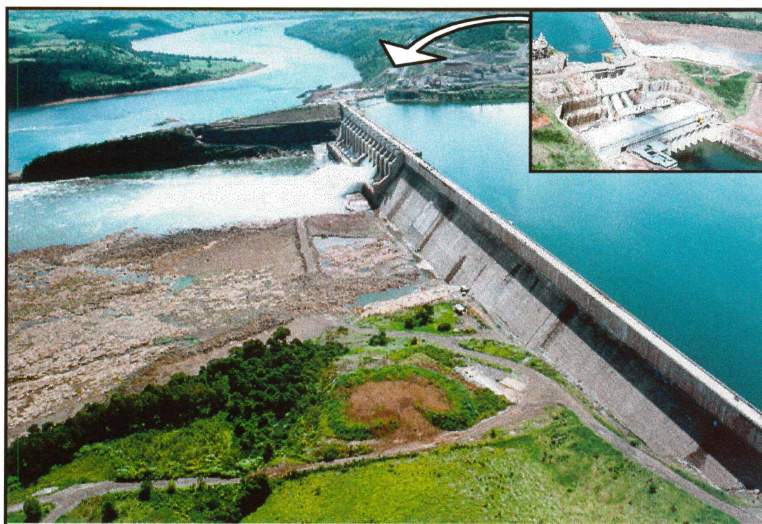
Figura 5.51 – Usina Hidrelétrica Salto Caxias – Vista aérea da barragem
