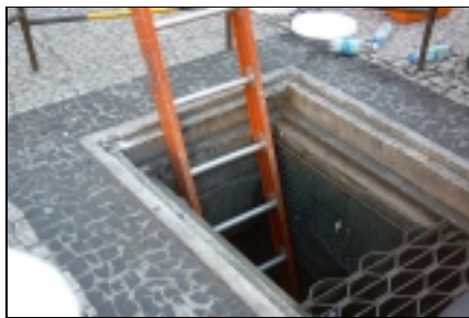
Acesso à câmara com retirada de grelha
