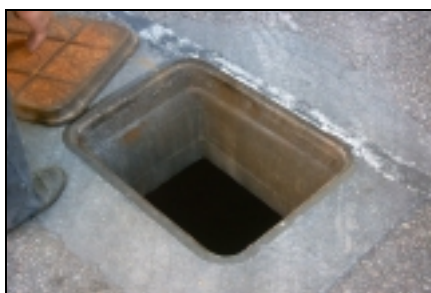
Abertura da tampa de ferro fundido
