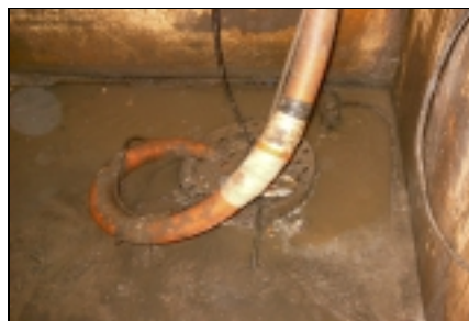
Utilização de bomba de recalque
