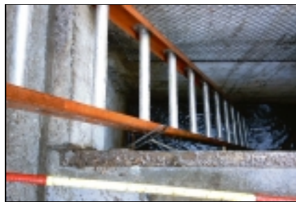
Água no interior da câmara
