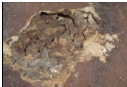
Nicho de concretagem
