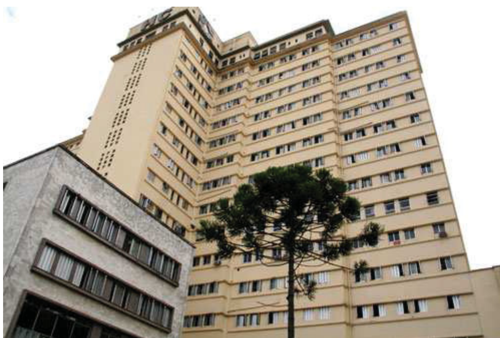
FIGURA 3 – FACHADA DO HOSPITAL DE CLINICAS DA UFPR
