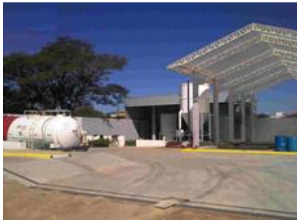
FIGURA 6 – ETE - ESTAÇÃO DE TRATAMENTO DE EFLUENTES BROOKS AMBIENTAL
