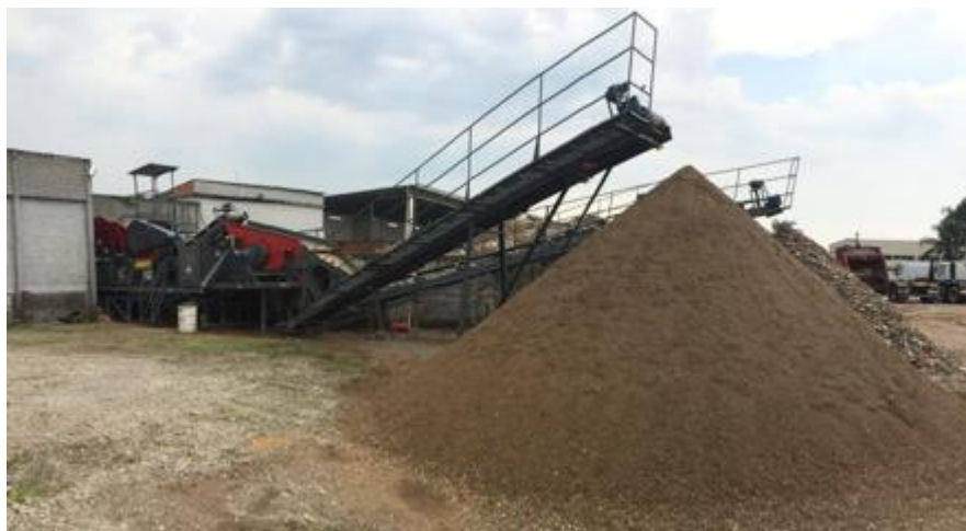
FIGURA 13 – BRITADOR DE RCD – RESÍDUO DA CONSTRUÇÃO E DEMOLIÇÃO
