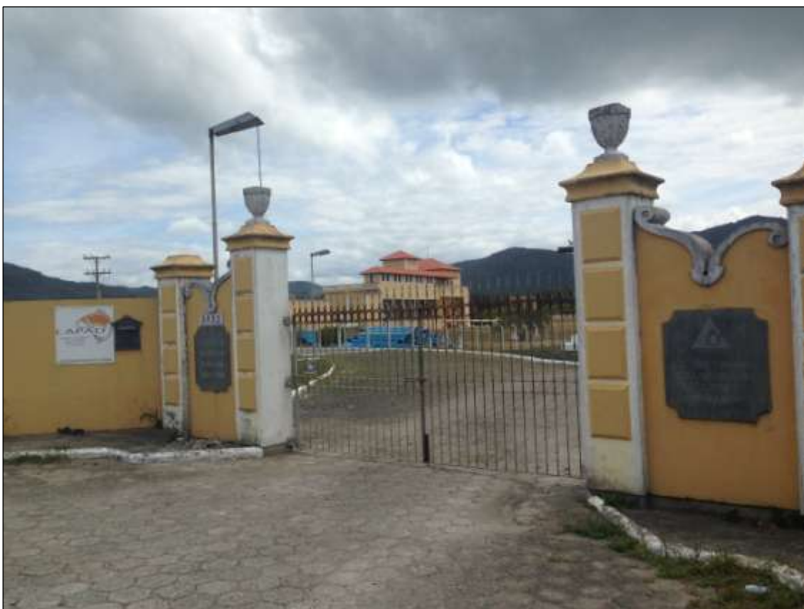
Figura 5. Local com instalações da CASAN e laboratório da UFSC, dentro do Parque Municipal da Lagoa do Peri.
