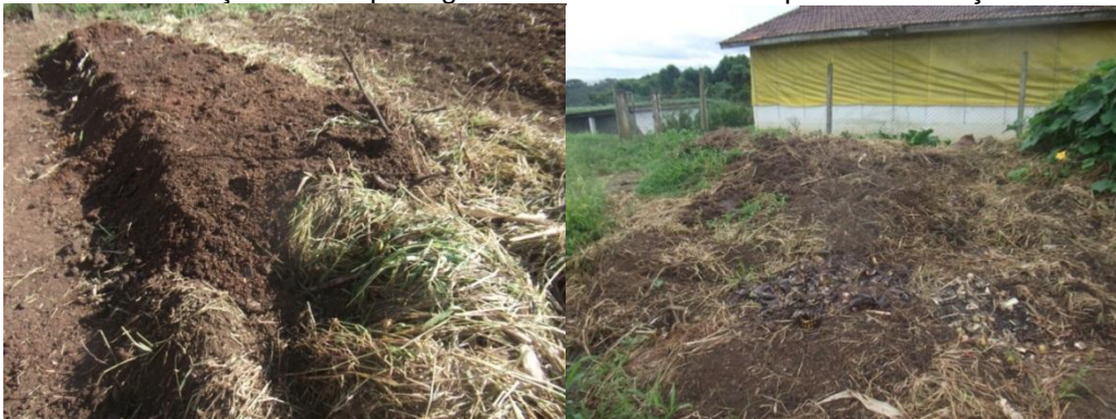
Foto 2 – Construção da compostagem e Materiais utilizados para a construção da compostagem
