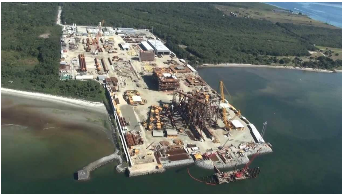
FIGURA 3: INFRAESTRUTURA DA TECHINT MULTINACIONAL ITALIANA FONTE: BANDA B
