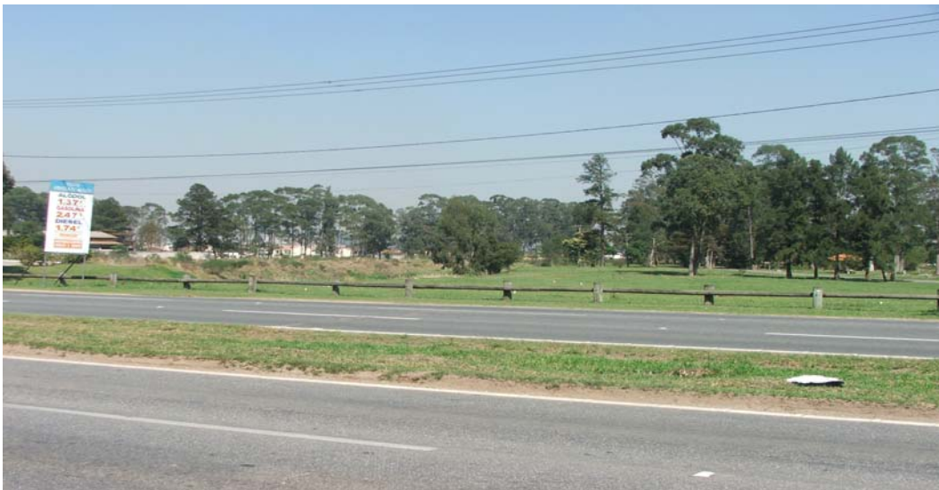
Figura 18 - Vista da Vala com Ocupação nas proximidades
