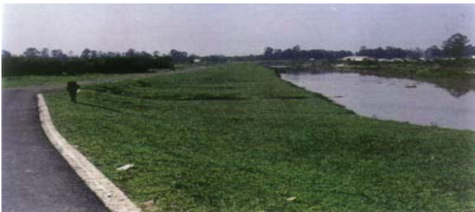
Figura 9 - Vista do Relevo da Área próxima a Via Marechal Floriano – Acesso ao Zoológico
