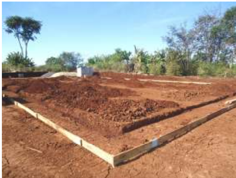
Figura 01: Início das obras de construção da agroindústria. (2011) Fonte: Arquivo Particular do Cursista. (2011)
