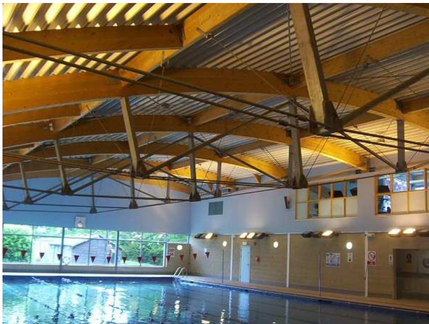
FIGURA 3 - COBERTURA DE UMA PISCINA CONSTRUÍDA COM MADEIRA LAMINADA COLADA
