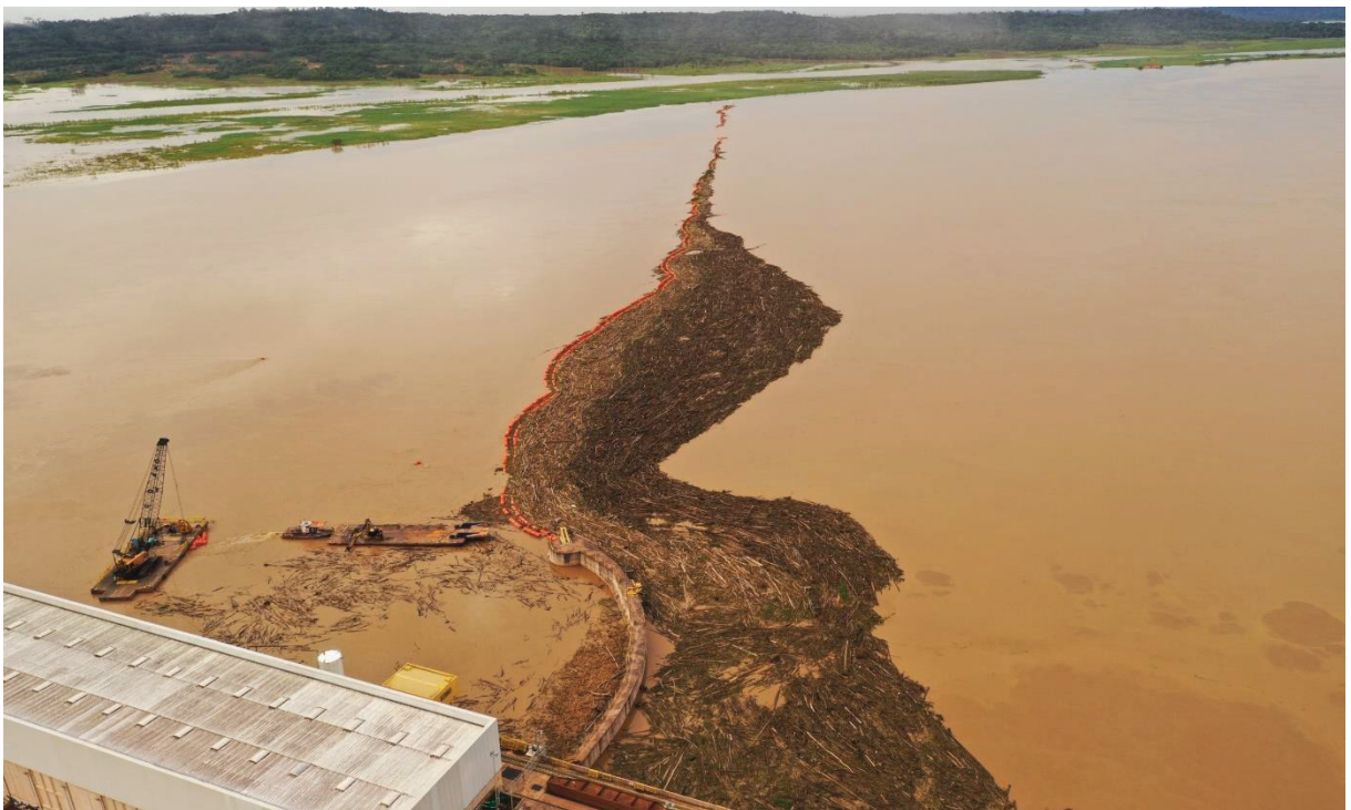
Figura 1 - Acúmulo de troncos nas linhas de log boom próximo as estruturas da UHE Jirau
